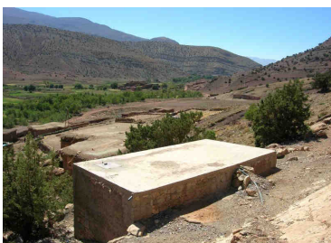
Château d'eau d'Ibakaliwane
