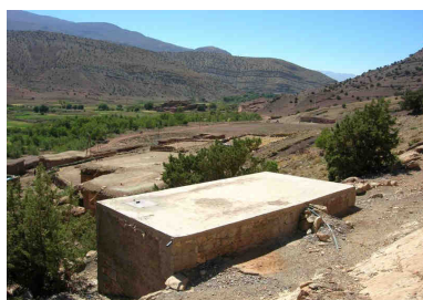
Château d'eau d'Ibakaliwane
