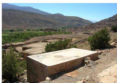
Château d'eau d'Ibakaliwane
